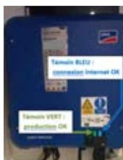
L'onduleur est équipé de témoins. En cas de fonctionnement normal de l'onduleur ci-contre, les deux voyants sont allumés. En cas de décrochage, le témoin rouge est allumé et le vert est éteint. De plus, en analysant les courbes de production grâce aux logiciels fournis avec l'onduleur, vous pourrez constater les interruptions de production.
