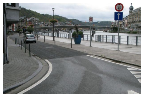
Changement de revêtement
