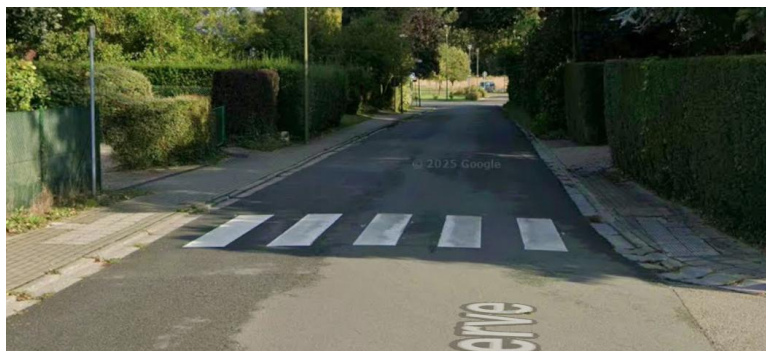
Exemple de traversées piétonnes avec dalles podotactiles (rue Minerve # Avenue Boischamps)
