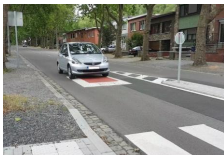
Installation d'un coussin
