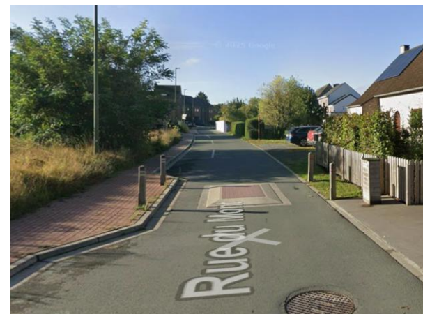
Exemple : Rue du Mont à Perwez
