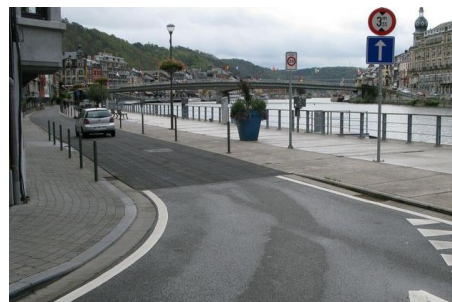
Changement de revêtement
