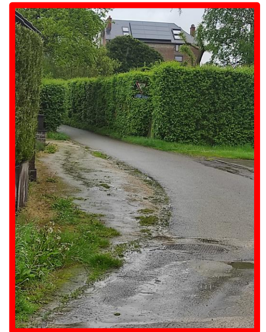
Absence de trottoir
