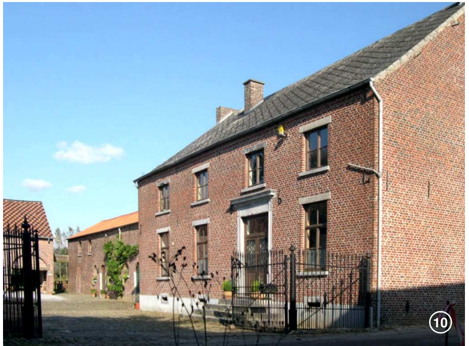
En bordure de l'Orne, la demeure de 1864 du propriétaire de l'ancienne brasserie de Noirmont domine une cour pavée autour de laquelle subsistent certains bâtiments d'exploitation.
